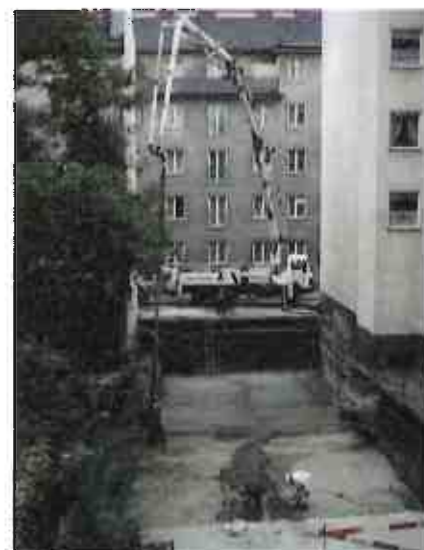
Lückenschluss – die Holzmeistergasse 7 wird gebaut
