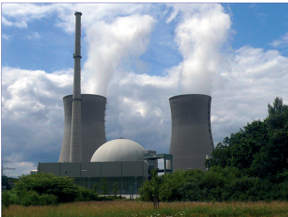
Deutsches Kernkraftwerk Grafenrheinfeld
