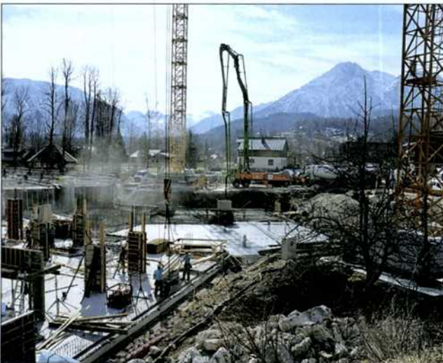
Mit zwei mächtigen Kränen wird die Baustelle beschickt.
