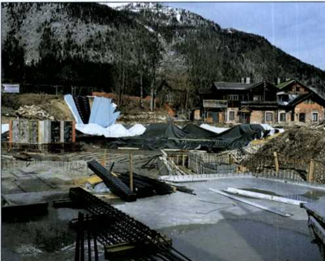
Auf der Baustelle am ehemaligen Areal des Park-Cafés konnte den ganzen Winter über gearbeitet werden.
