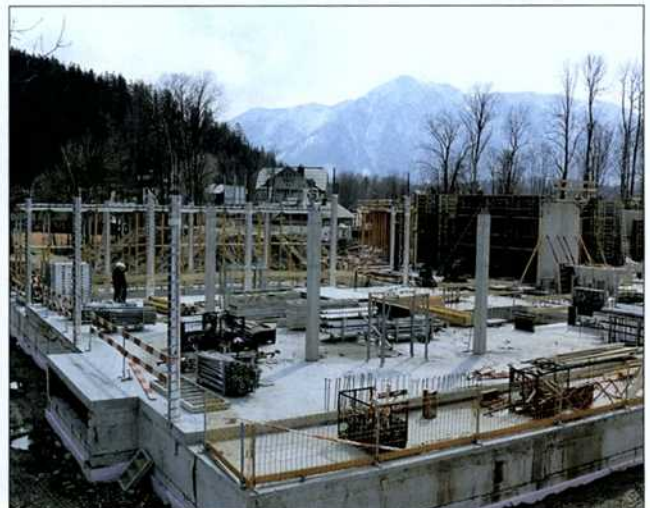
Unter dieser Decke verbirgt sich die Tiefgarage. Wie man sieht, sind auch die Betonierarbeiten schon sehr weit fortgeschritten.
